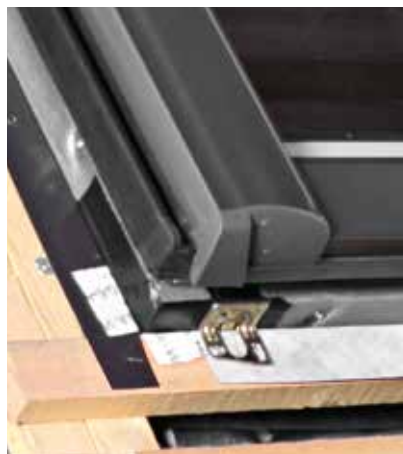
Wykonanie uszczelnienia wodoodporną taśmą dookoła okna.
