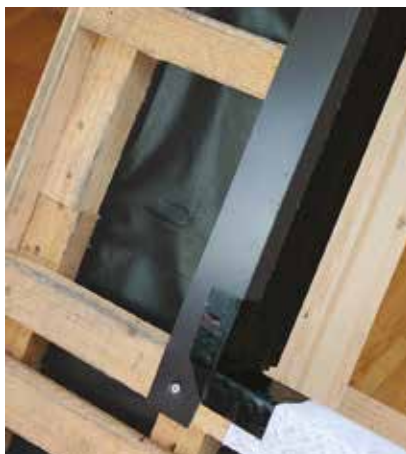
Montaż profili aluminiowych i narożników oraz szczelne połączenie z folią dachową.
